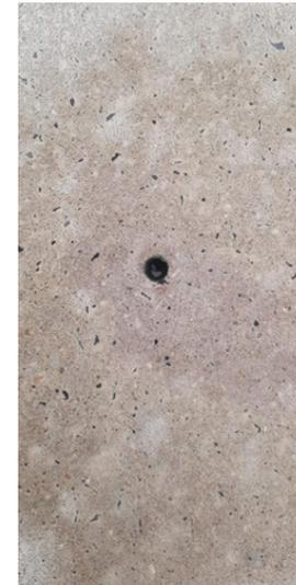
Voilà le résultat après forage et après enlèvement de la rouille des pores au moyen de Lithofin Rost-Ex
