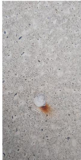
Voici à quoi ressemble un noyau de pyrite après forage ; la profondeur varie de 0,5 cm à 2 cm
