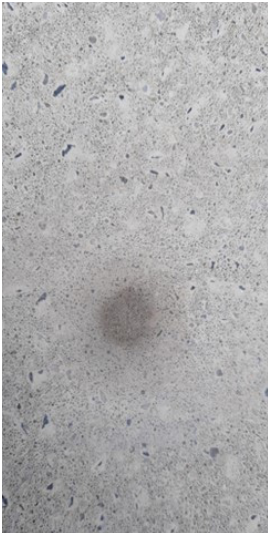
Wrijf het oppervlak vlak met een vochtige doek en laat het verder uitdrogen
