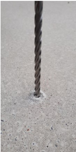
Boor de pyriet eruit met behulp van een kernboor, dia 10-15mm
