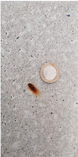
Behandel een pyrietvlek liefst vanaf de beginfase Bepaal de pyrietkern
