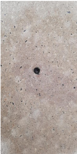
Dit is het resultaat na het uitboren en nadat de roest uit de poriën gehaald is dmv Lithofin Rost-Ex
