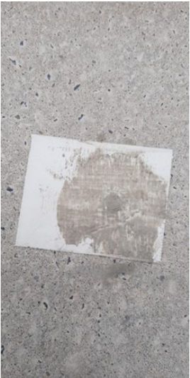
Laat \frac{3}{4} van de herstelpasta ongeveer 2 uur uitharden
