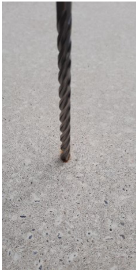
Behandel een pyrietvlek liefst vanaf de beginfase Bepaal de pyrietkern
