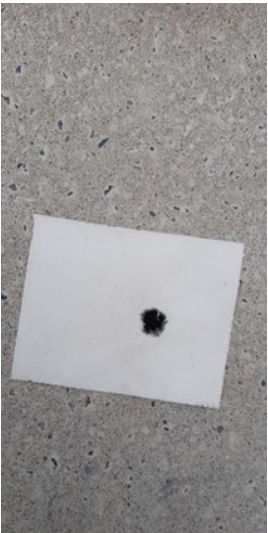
Breng tape aan en doorboor die zodat de herstelpasta iets hoger kan worden aangebracht
